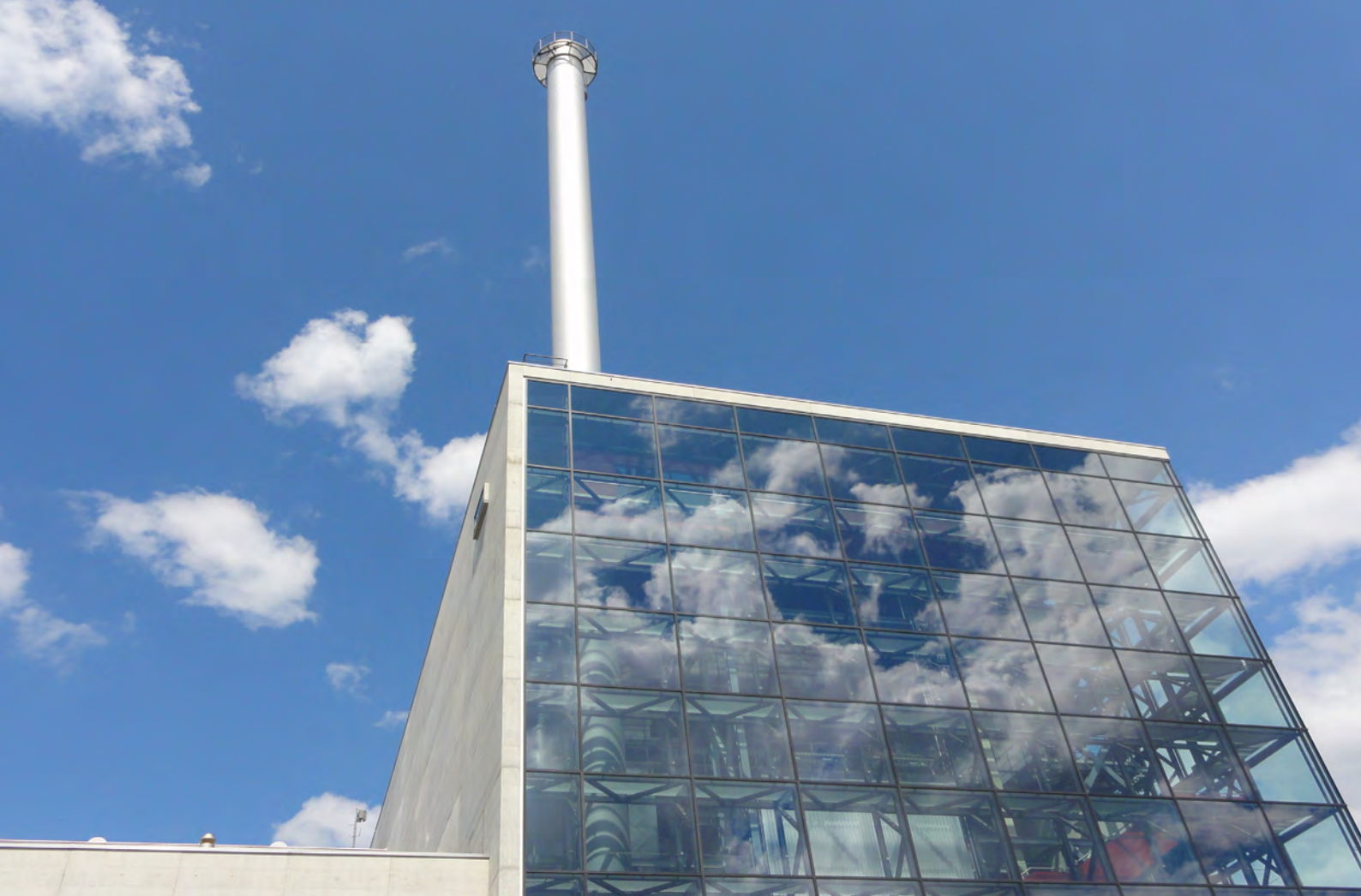
Kehrlichtverwertungsanlage KVA Thun
